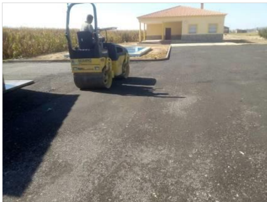
Ilustración 10. Aplicación de árido reciclado en una explanación.
